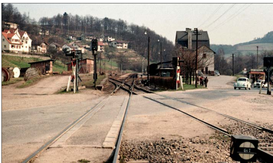
Direkt aus dem Bahnhof Unter-Waldmichelbach ging es über eine Dkw in den Anschluss der Hölzerwerke. Dabei wurde auch die Landstraße von Mörtenbach gekreuzt. Foto: wk, Sammlung HM
